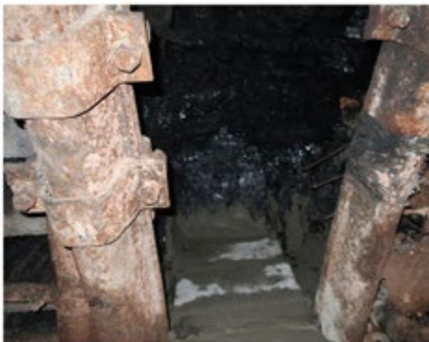
FOT. 2. Budowa obmuru korka hydroizolacyjnego.
